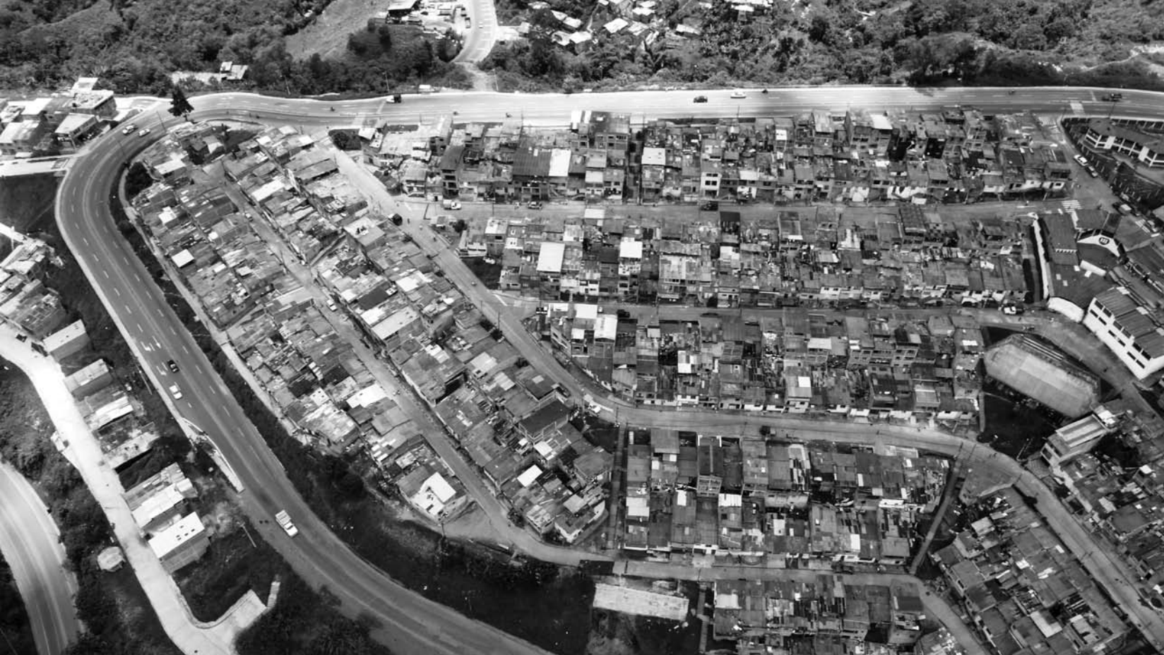
Foto 1: barrio El Paraíso. Autor: Zepelín, foto tomada especialmente para el proyecto
