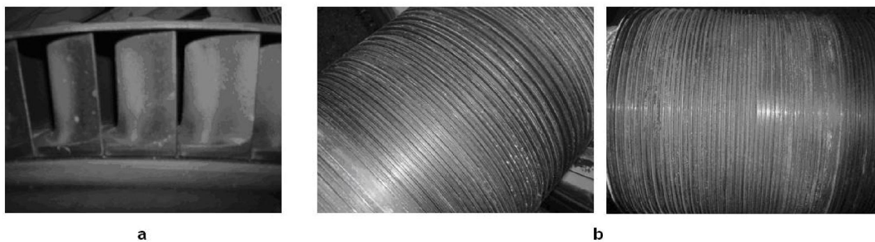
Figura 9. Fotografías de la turbina 1 mostrando el buen estado técnico de alabes (a) y sellos (b).
