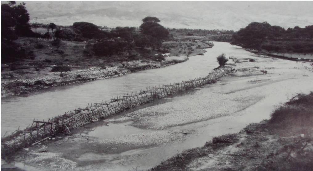
Figura 4. Obras de rectificación del río de Medellín entre 1941 y 1942
