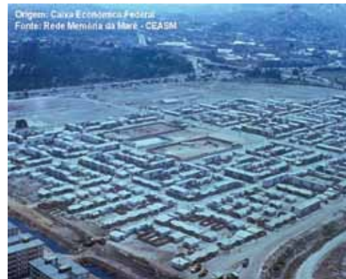
Figura 4. Vista aérea da Vila do João em construção. Ao fundo, a Avenida Brasil.
