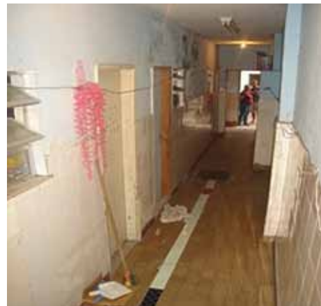
Figura 13. Corredor de um edifício "cortiço" no Complexo da Maré, em 2008. Fotografia de Vinícius Lucas Santana, agosto 2008.
