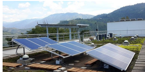
Figura 2. Paneles FV instalados sobre la terraza del Edificio de Ingeniería Eléctrica. Fuente. Elaboración propia.
