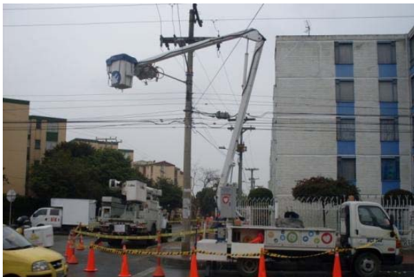
Figura 13. Instalación RC Móvil
