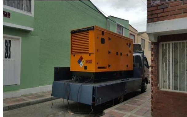
Figura 9. Instalación de grupos electrógenos e baja tensión
