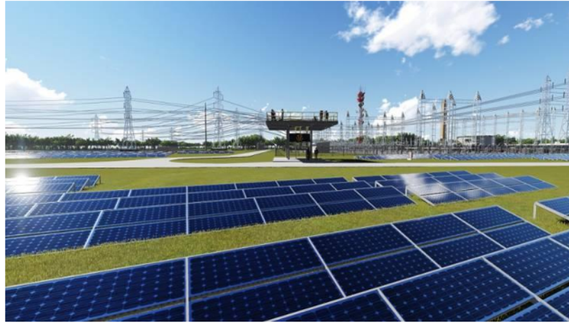
Celsia (9,9 MW) – Cali-Colombia
