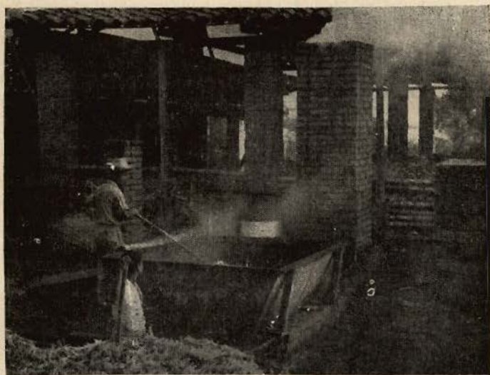
Figura 2.— Deshidratación de la cachaza en una hornilla construída para el efecto.
