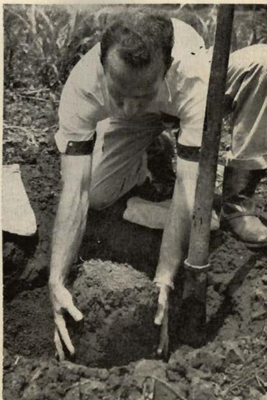
FIGURA 1: Excavación que muestra la manera de extraer el bloque de suelo.
