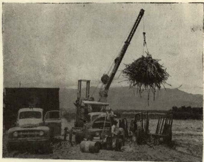
Figura 8. — Grúa sacando la caña de los vagones para colocarla en los camiones de transporte.
