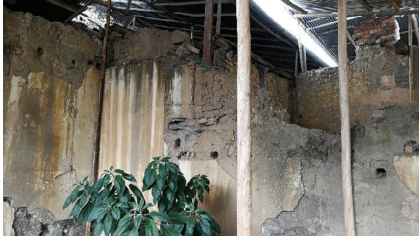
Figura 2. Ejemplo del mecanismo de daño de la humedad (2019).
