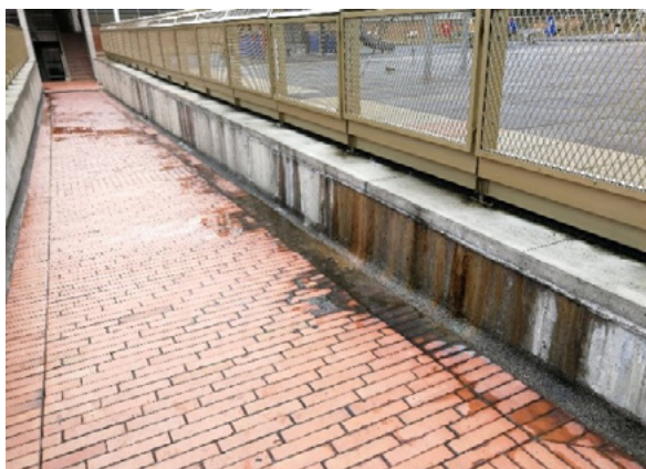
Figura 7. Ejemplo de humedad con varios mecanismos de daño al tiempo (2017).
