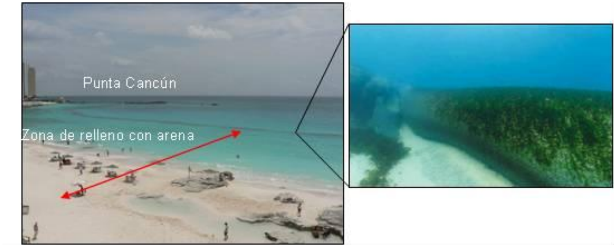
Figura 3. Sector norte de Cancún luego de la colocación de arena y los geotubos (poco visibles para un turista inadvertido)
