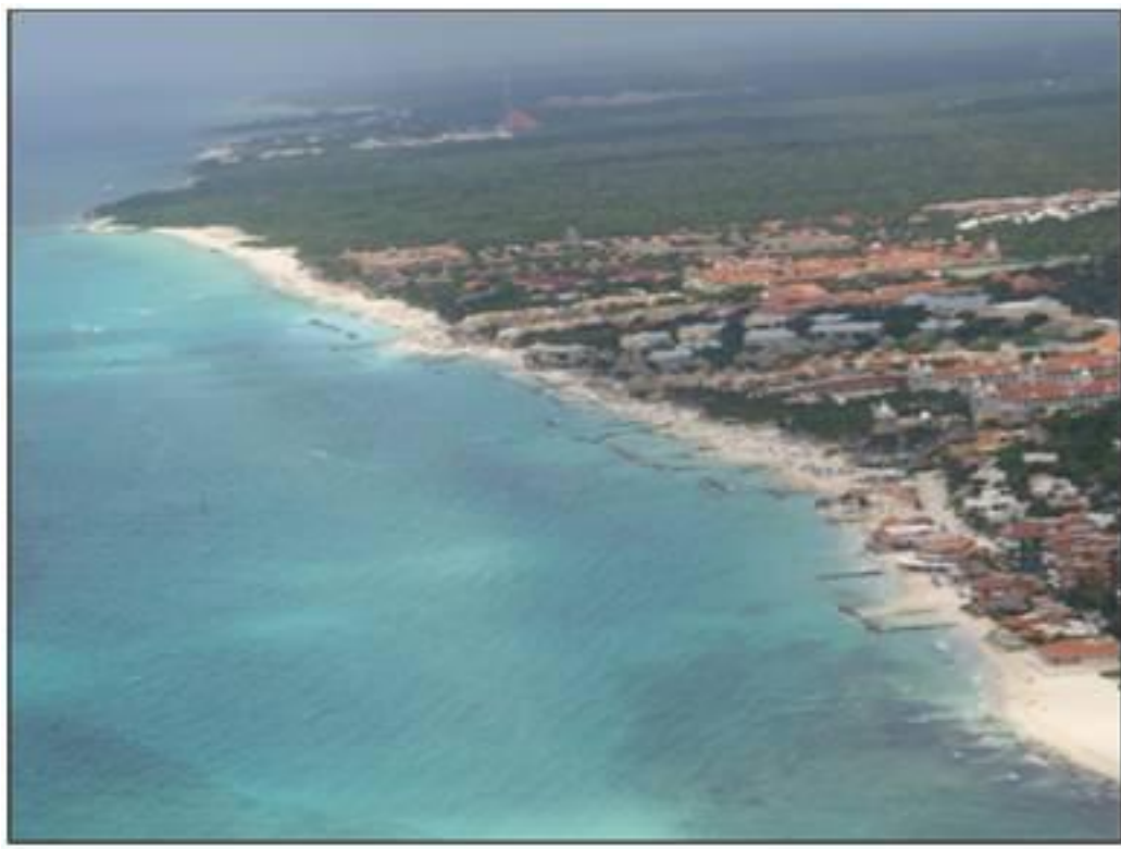
Figura 8. Estructuras de protección (geotubos) instalados de manera indiscriminada en Playa del Carmen
