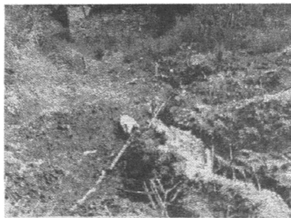
FIGURA 4. Sistema de drenaje usando filtros en guadua ( Guadua angustifolia ) y gravilla.
