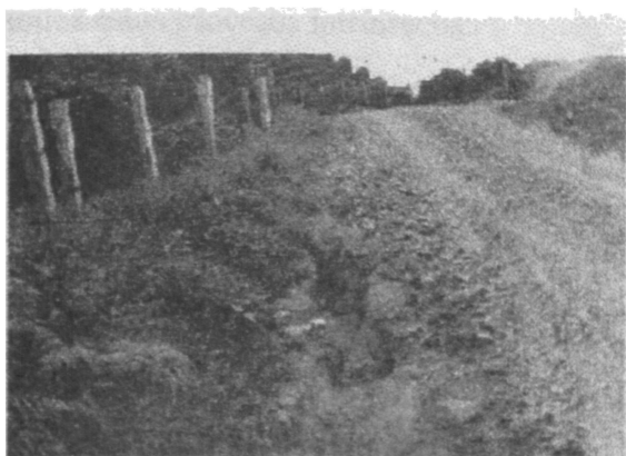
FIGURA 2. Cárcava profunda en cuneta de carretera por ausencia de coberturas vegetales.
