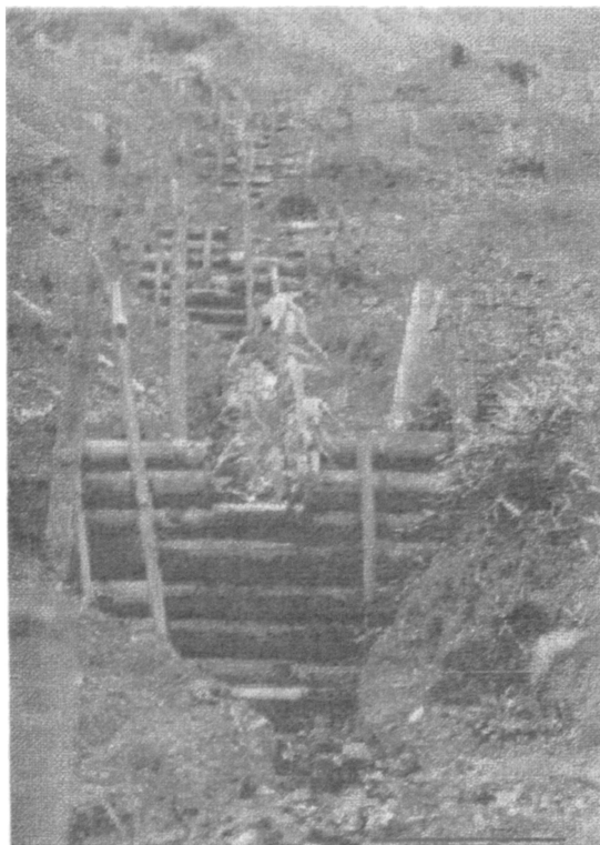
FIGURA 6. Evacuación de aguas superficiales mediante trinchos hechos en Guadua ( Guadua angustifolia ). Fincas Providencia y la Aurora (Palestina - Caldas).
