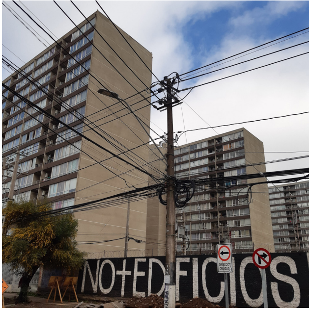
Figura 5. Mural realizado por el movimiento “No + Edificios ilegales”, en la comuna de San Miguel Fuente: Autores.
