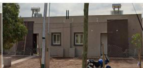
Viviendas paneles EPS, malla y cemento
