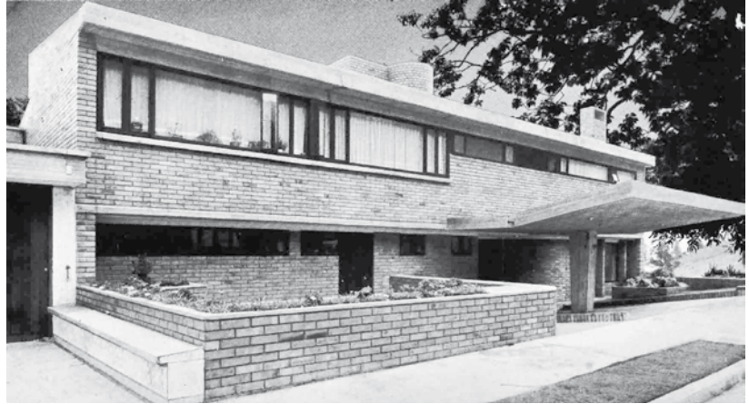
3b. Fachada este. Fotografía Hernán Díaz.
