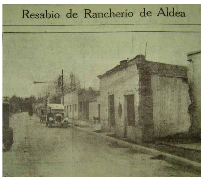
Figura 1. Casa antigua que no respeta las líneas municipales. Fuente: La Libertad , 6 de febrero de 1939, s.p.
