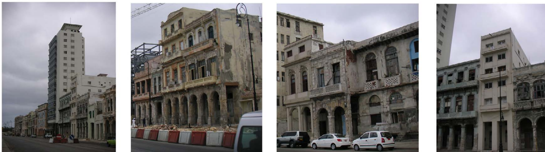
Imágenes que muestran el avanzado grado de deterioro de las edificaciones del Malecón Tradicional
