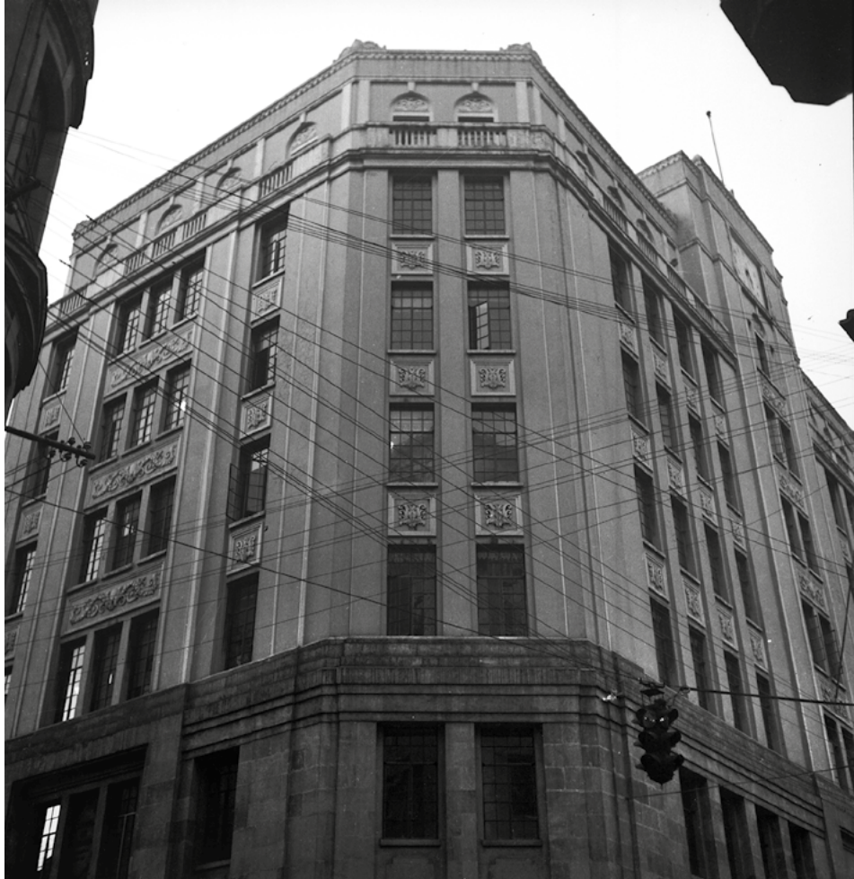
Figura 6. Edificio bancario en el centro de Bogotá
