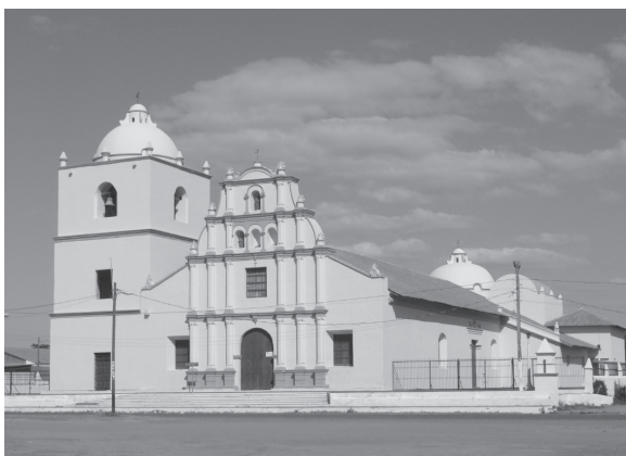
Figura 6. Iglesia San Juan Bautista de Sutiaba, enero de 2010, después de los trabajos de renovación emprendidos para el 4to. centenario del traslado de León a los parajes de Sutiaba. Fuente: archivo personal del autor, 2010.
