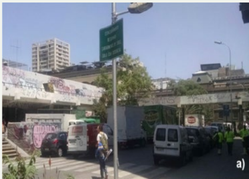
Pasarela sobre la calle Carabineros de Chile
