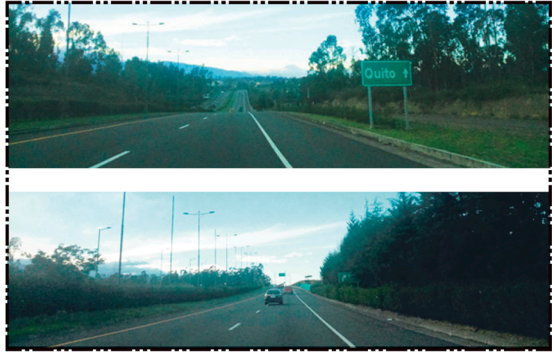
Conector Alpachaca - Vía principal de ingreso al NAIQ
