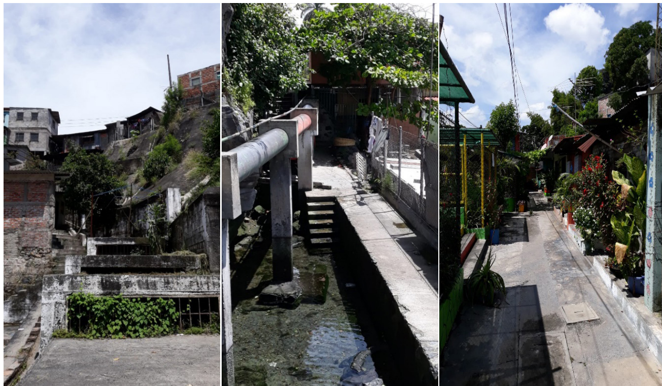
Imagen 2. Mejora ambiental del espacio público e introducción de redes de saneamiento en el barrio de Los Manantiales en San Salvador (El Salvador)
