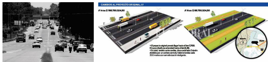
Figura 4. Remodelaciones Ruta Provincial n°1: Ampliación década 1990 (Izq.); ampliación entre 2011 y 2017 (proyecto original y proyecto con presupuesto reducido en un 50%) (Der.) Fuente: Diario El Litoral
