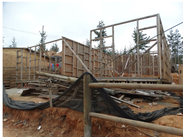
Figura 5. Viviendas en proceso de construcción en el campamento Fuente: elaboración propia
