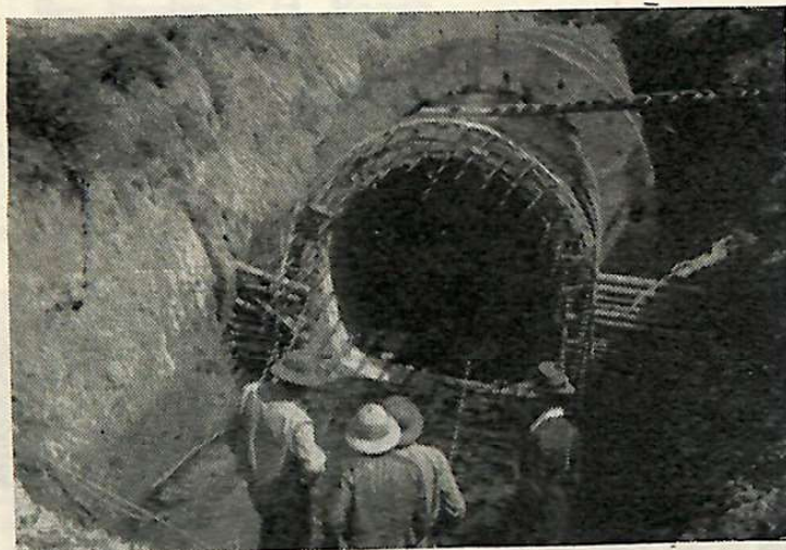
Sección del desagüe de fondo
