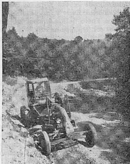
Motoniveladora limpiando zanjas. Esta máquina versátil es una absoluta necesidad para la eliminación de encalaminado en las superficies de caminos de grava y para la redistribución de material suelto.
