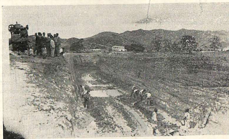
Excavación para uno de los Colectores principales.
