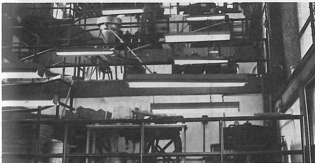
"Otro aspecto parcial de la planta piloto de concentración de minerales del CENTRO DE INVESTIGACION DEL COBRE. Fotografía de Guillermo Enrique Escobar".
