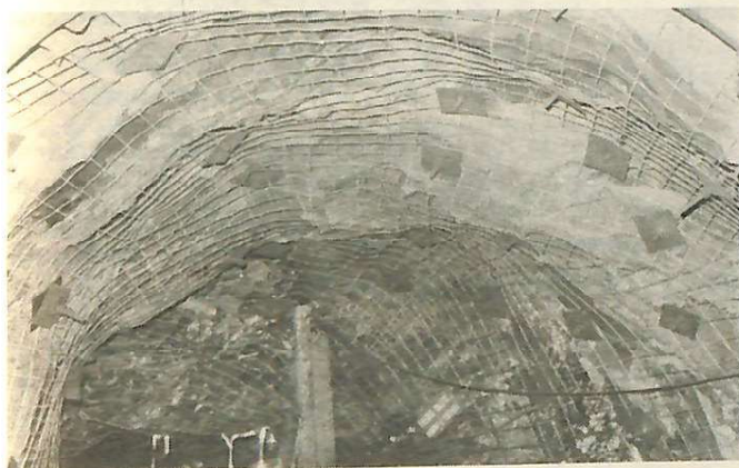
Foto No. 1. Fortificación de una galería utilizando pernos.
