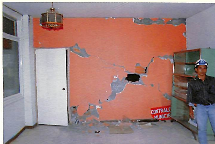
Figura 17 Muro interior de relleno de pórtico
