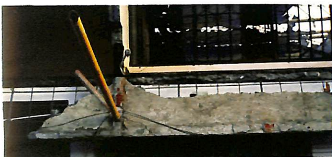
Figura 16. Voladizo colapsado por acero mal colocado
