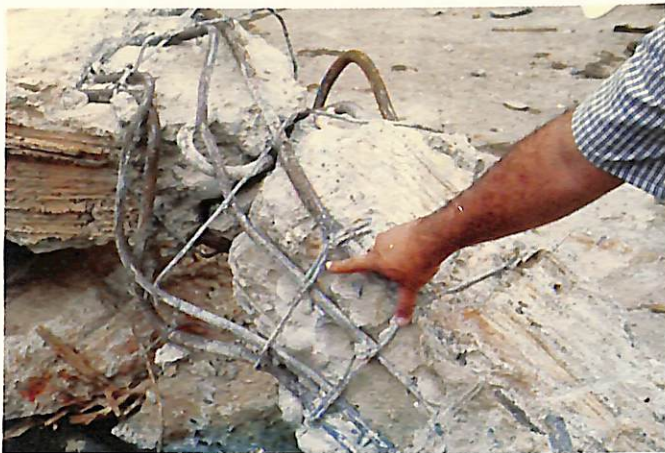
Figura 11 Insuficiente confinamiento
