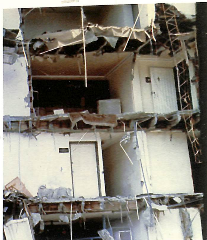
Figura 13 Colapso parcial por cambio de rigidez
