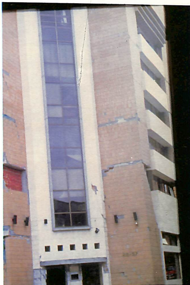
Figura 18 Enchapes de fachada con colapsos parciales
