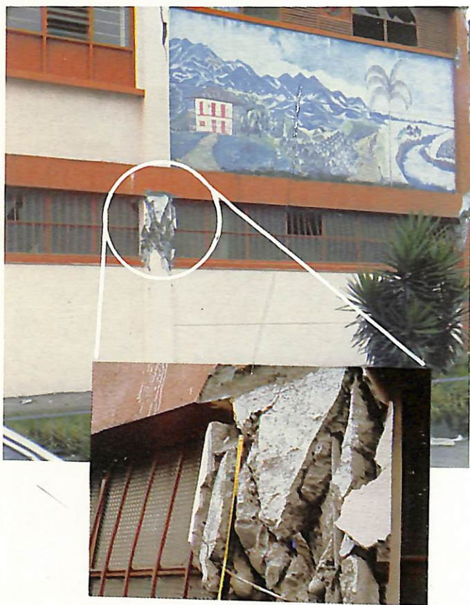
Figura 12 Efecto de columna corta en edificio de un colegio en Armenia que colapsó parcialmente
