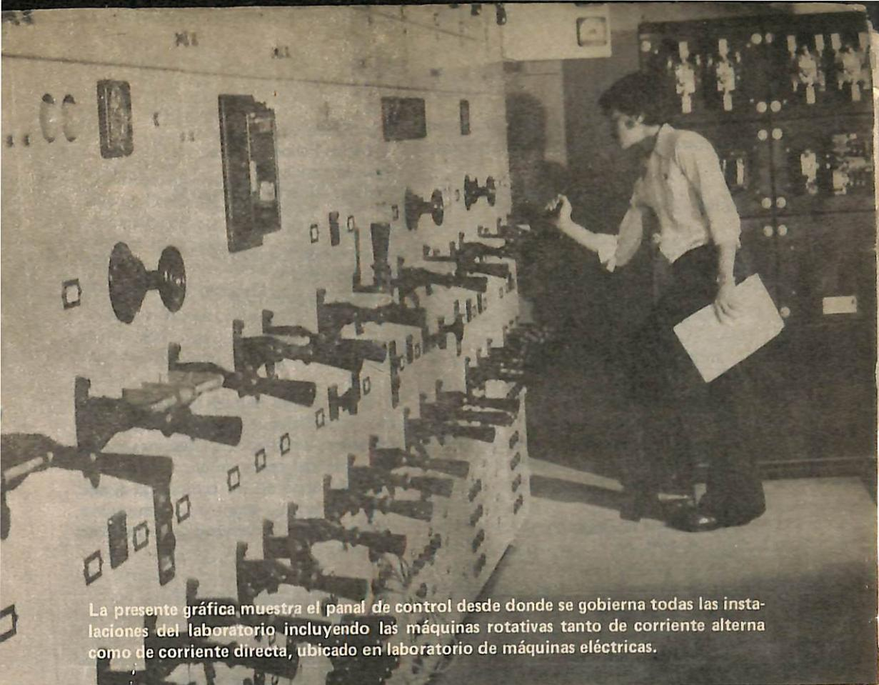
La presente gráfica muestra el panel de control desde donde se gobierna todas las instalaciones del laboratorio incluyendo las máquinas rotativas tanto de corriente alterna como de corriente directa, ubicado en laboratorio de máquinas eléctricas.
