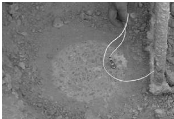
Figura 4. Superficie preparada para la prueba PIT Figure 4. Pile surface prepared for the PIT
