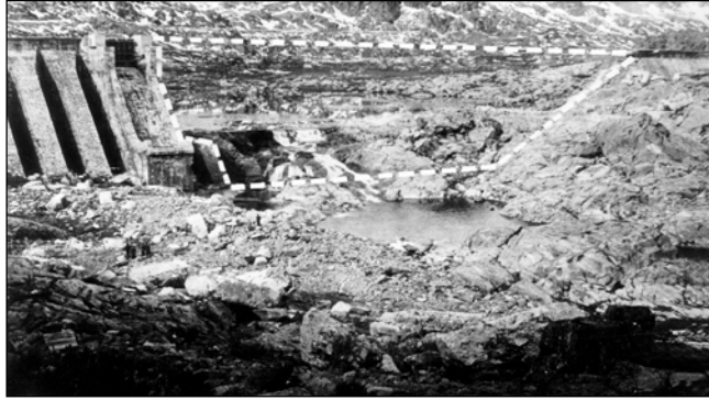
Figura 2. Imagen de la presa rota (1959). Fuente Archivo Histórico Provincial de Zamora
