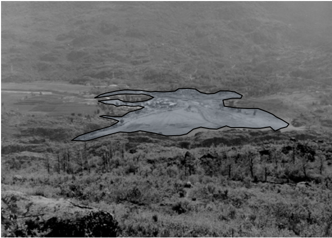
Figura 8. Vista general de la zona afectada por la avenida en la llanura de Ribadelago. Fuente Archivo Histórico Provincial de Zamora
