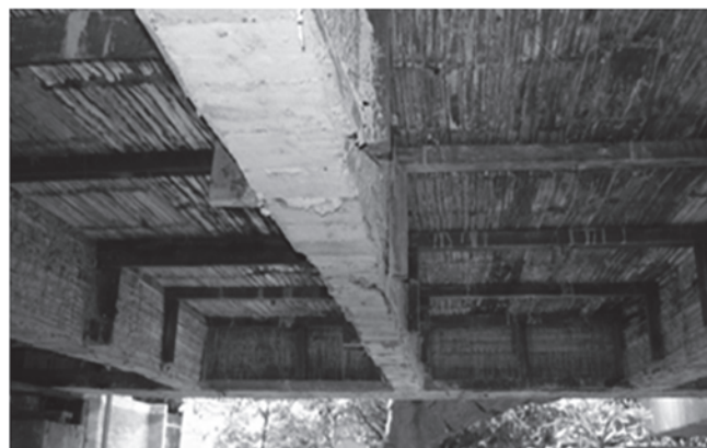
Figura 2. Plataforma experimental T1: losa aligerada con casetón en esterilla de guadua [14]
