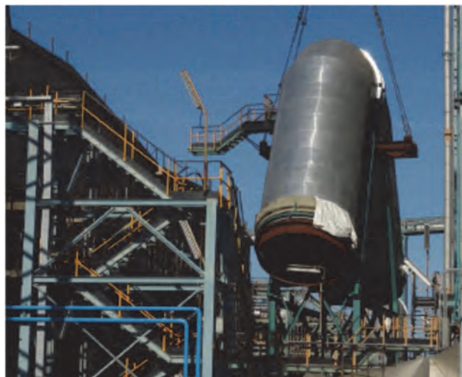
Figure 9. Instalación del conducto de equilibrio del ingreso. Fuente: Fotos propias.
