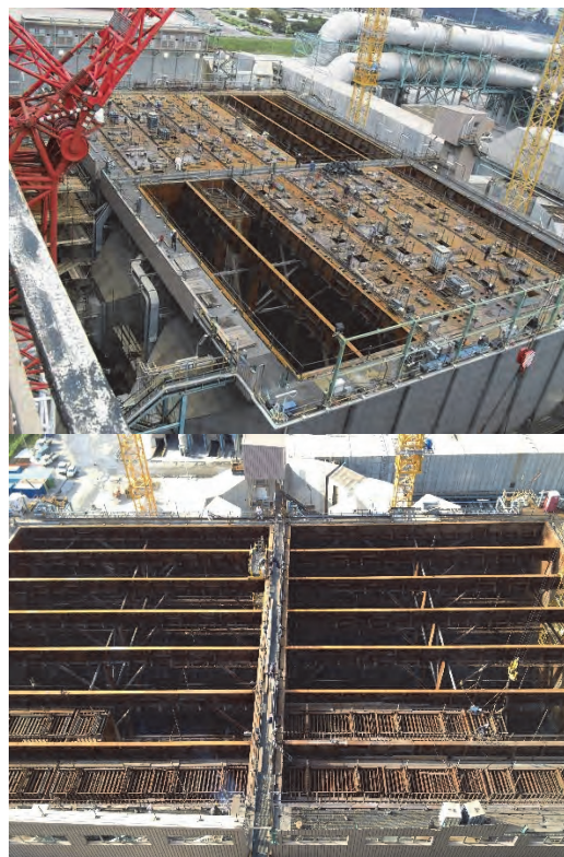
Figura 1. Arriba) Demolición del techo. Abajo) Ultimación de la extracción de todas las placas colectoras.
