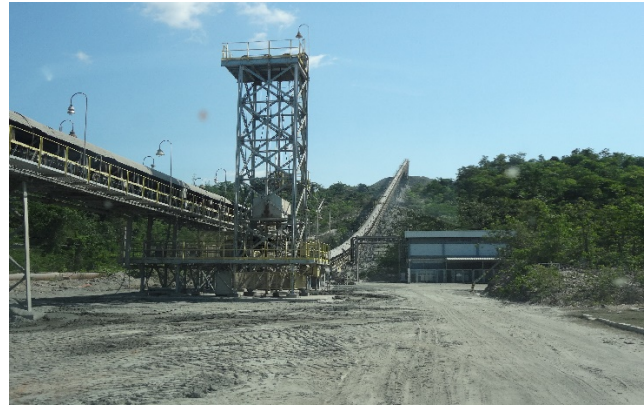
Figura 10. Correa transportadora de una mina de cobre al sur del estado de Pará - Brasil.
