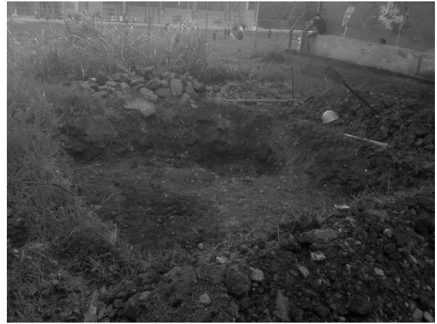
Figura 1. Terreno adecuado para la experimentación de este trabajo. En la figura se muestra la excavación de una cavidad de 3mx3m por 1m de profundidad.
