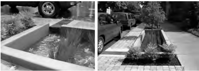
Figura 6. Propuesta de sistema de drenaje en SW 12th Avenue Green Street, Portland, Oregon. Fuente: Tomado de [16]
