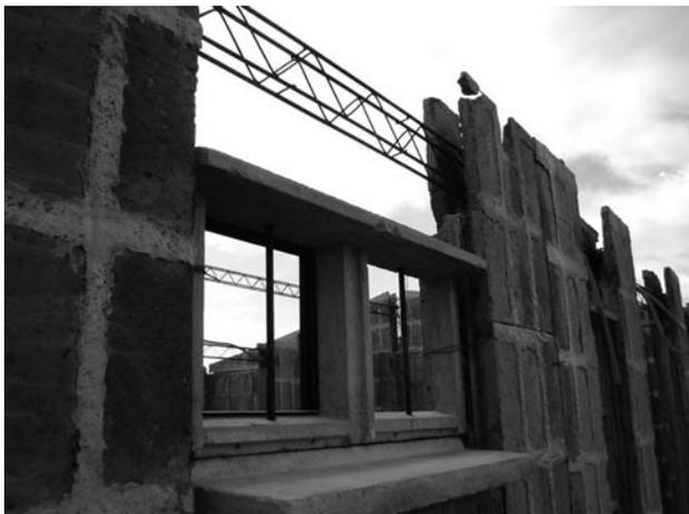
**Techo y Cubierta:** el techo es también de placas cerámicas armadas, apoyadas sobre viguetas premoldeadas de hormigón. Sobre ellas se realiza la capa de compresión y luego se completa la cubierta con cualquier material aislante del mercado.
