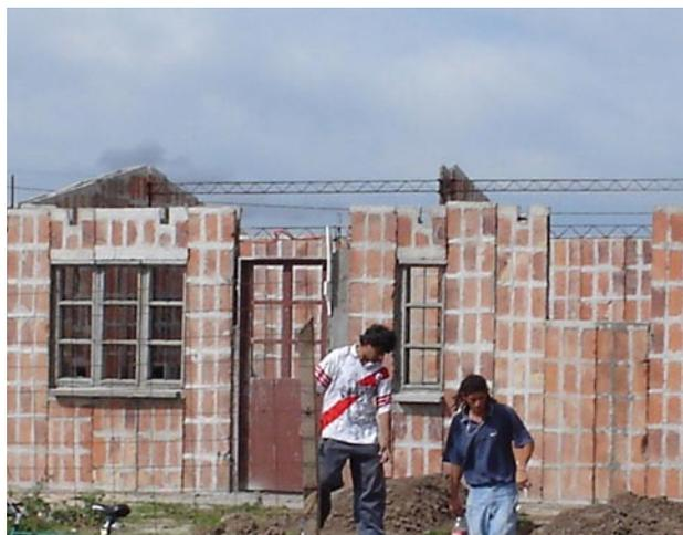
**Aberturas:** ventanas de hormigón, puertas exteriores metálicas e interiores tipo placa, con marco metálico. El sistema puede ajustarse para utilizar ventanas del mercado.
