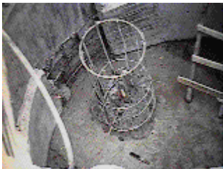
Cabezal de un pilote fundido in – situ
