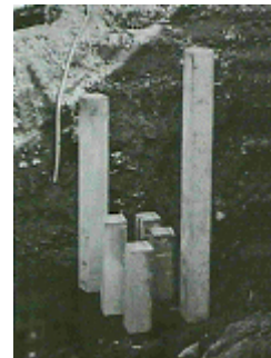
Pilotes prefabricados colocados
