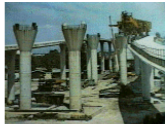
Pilas de puentes
