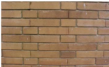
Aparejo de los muros de mampostería
