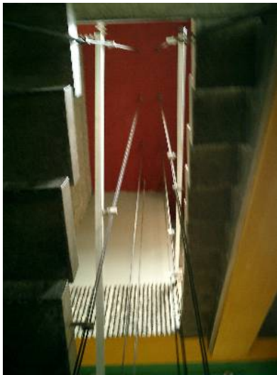
Las escaleras al interior de una de las "cajas"
