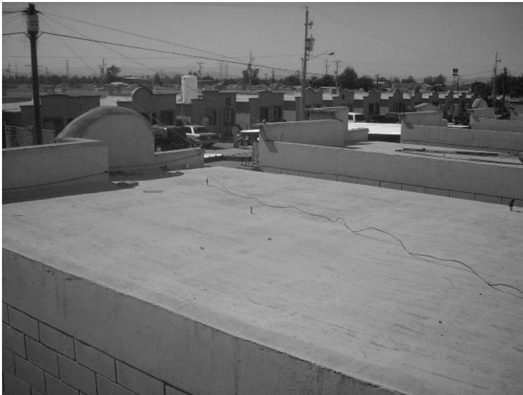
Figura 1. Vivienda de muros de bloques de cemento-arena y techo de concreto reforzado
