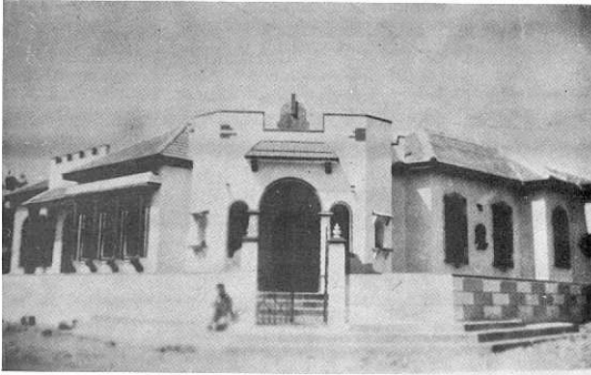
(1945) Fachada principal de la vivienda de doña Bertha Chaddid de Jattin. Fuente: José L. Córdoba.
