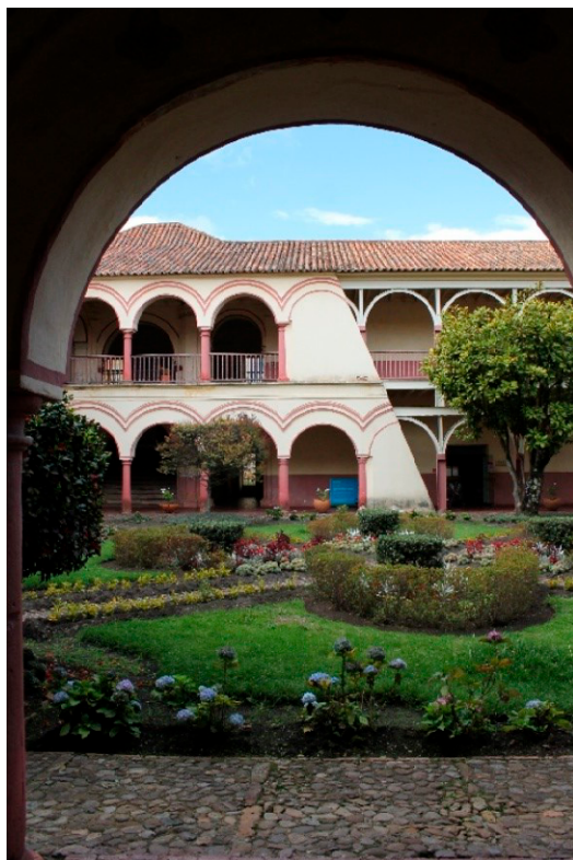
Figura 4. Aspectos de la primera restauración del claustro agustino, Tunja
