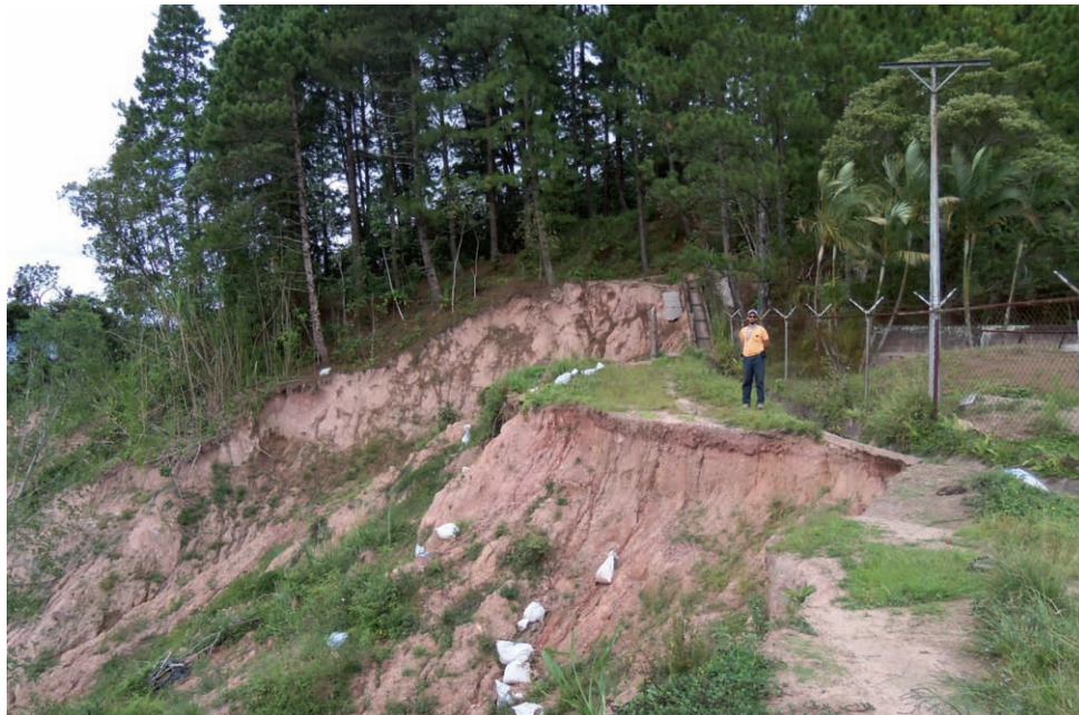
Figura 7. Vista lateral de la corona de deslizamiento en el talud señalado con la letra A en la figura 6, después de su reactivación por las lluvias de finales del 2010. Fotografía: Rodríguez (2012).
