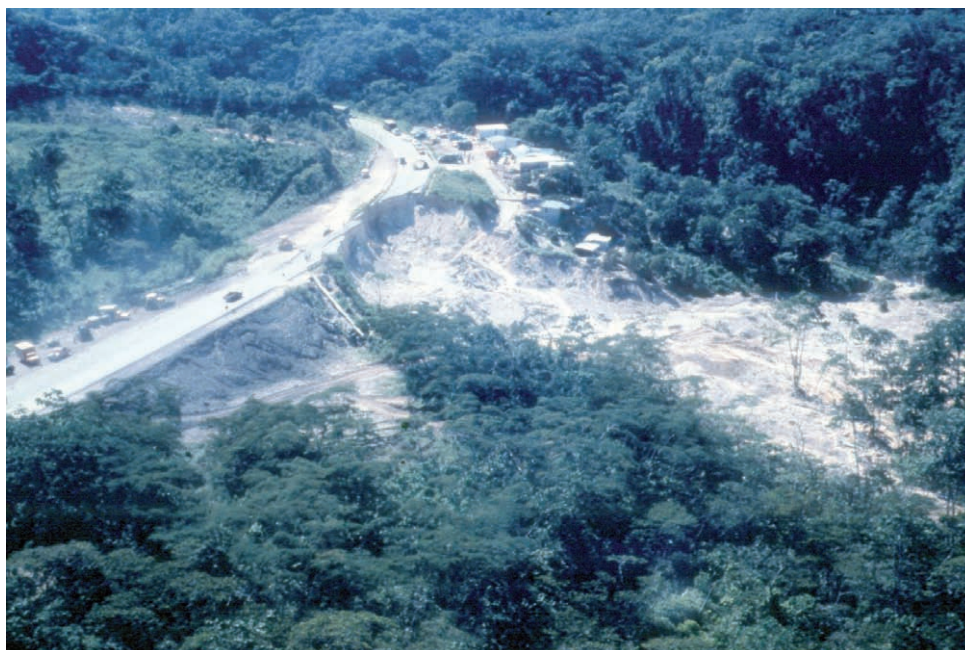
Figura 4. Colapso cosísmico del terraplén de San Josesito por un flujo de barro y destrucción del barrio marginal ubicado al pie del talud. El tramo de la obra, reconstruido en 1978, se observa a la izquierda de la cicatriz de colapso. Fotografía cortesía Ing. Roberto Centeno (1981).
