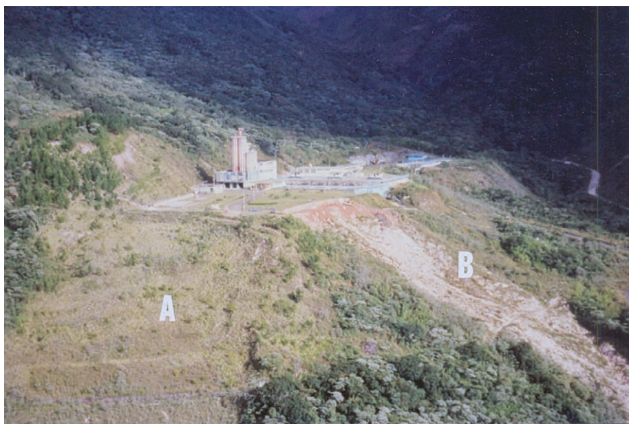
Figura 6. Vista panorámica del sitio de planta de San Rafael de Cordero. En el talud de bote B, huellas frescas del deslizamiento cosísmico de 1989 en el terraplén y vía de acceso a la planta. En el talud de bote A huellas de bermas destruidas, acondicionadas en ocasión de un deslizamiento ocurrido en 1984. Fotografía: Singer (1989).
