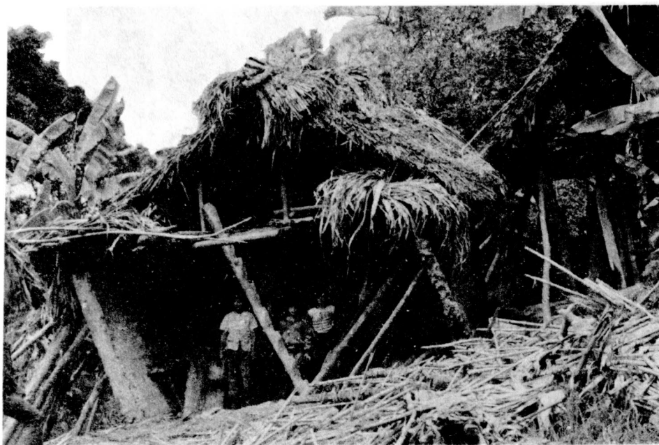
FIG. 11: Casa averiada, inclinada pendiente abajo, en el sector SW del área afectada en el valle de la Q. Barroso.
