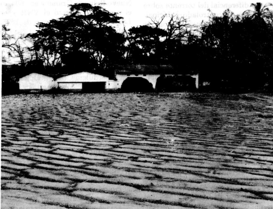
**Fig. 13.** Aspecto de los destrozos causados por el tramo distal del flujo de lodo del 13.11.1985 en el caserío de Santuario. Nótese la ausencia de material grueso en la superficie, las marcas del flujo de lodo en las paredes y las grietas de desecación. Algunas paredes, perpendiculares a la dirección de la corriente cedieron al empuje de la avenida; los muros paralelos al flujo permanecieron intactos. Foto tomada hacia el oriente, el 25 de Enero de 1986.
