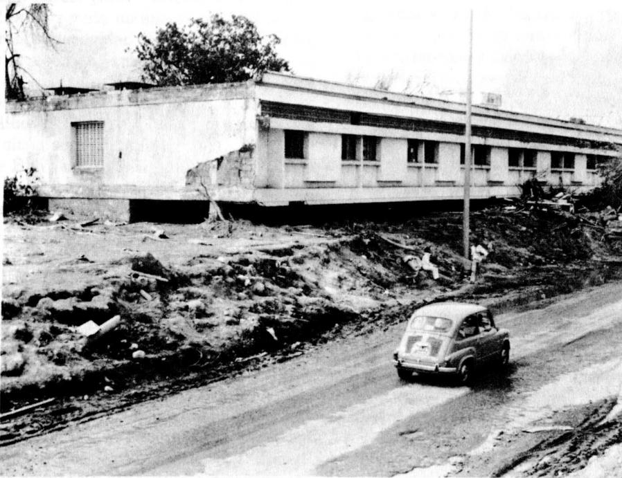
Fig. 9. Otra vista del sector afectado por la fase espesa del flujo de lodo. La edificación corresponde al hospital de Armero, situado al lado de la vía que atraviesa la población y que comunica a Ibagué con Honda. La carretera, limpiada hasta el nivel del asfalto, permite apreciar bien la altura del lodo, en este punto cercana a 2 m.
