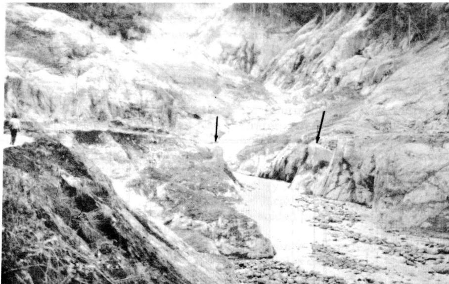
Fig. 4. Vista del cauce del Río Azufrado, donde se observan los restos de los estribos del puente (flechas) entre Villahermosa y Casabianca. Se aprecia también claramente la altura que alcanzó el flujo (a modo de escala, la altura del estribo del puente está a 12 m sobre el lecho del río). Se nota también el total arrasamiento de la capa de suelo y la cubierta vegetal.
