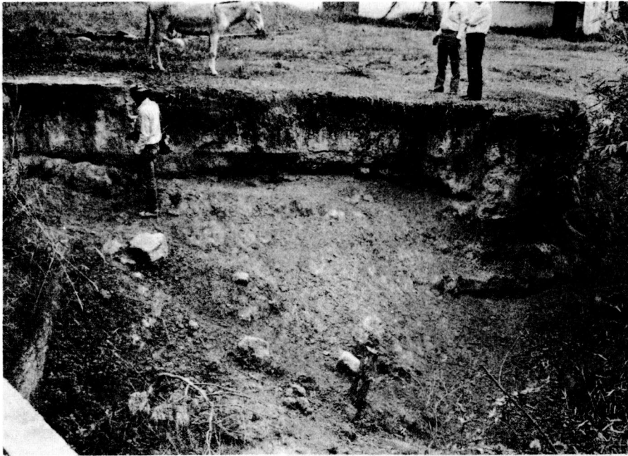
Fig. 20. Margen oriental del Río Lagunilla en la concentración escolar de El Danubio, 3 km al SW de la desembocadura en el Río Magdalena. En la parte baja se aprecian sedimentos arenosos sueltos, recubiertos por un delgado flujo de lodo (pequeño talud vertical), cuyo límite inferior es claramente erosivo. La erosión regresiva, causada aquí por un canal de "cosecheros y desechos", amenaza con destruir las construcciones. El afloramiento se encuentra a unos 100 m del cauce actual del Río Lagunilla.
